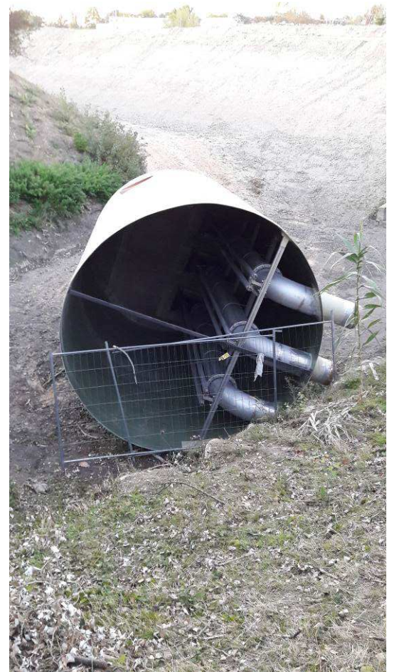
Livraison de la cuve pour le nouveau poste de refoulement
