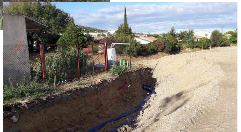
Purge de la virole du poste de refoulement, système de refoulement provisoire mise en place.
