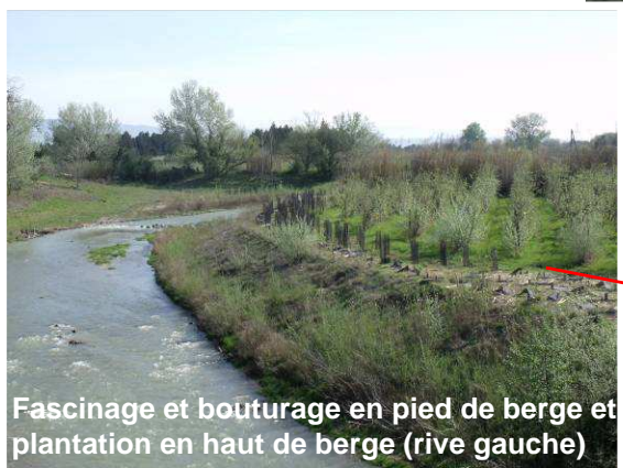
Fascinage et bouturage en pied de berge (rive gauche)
